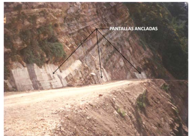
Figura 8. Pantallas ancladas construidas a lo largo de las capas de arcillolitas inferiores
